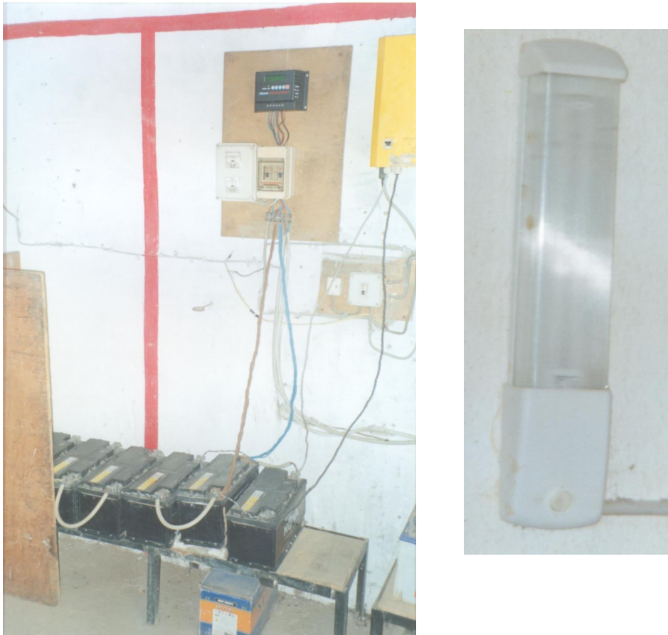
Photo 6 : Batteries, Contrôleur de charge et réglettes au CEFAVIHAR de Blangoua
